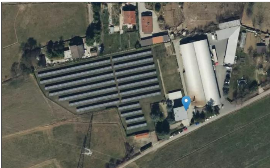
Figura 1: Stabilimento Elettromeccanica Piosasco di Piosasco (TO).
