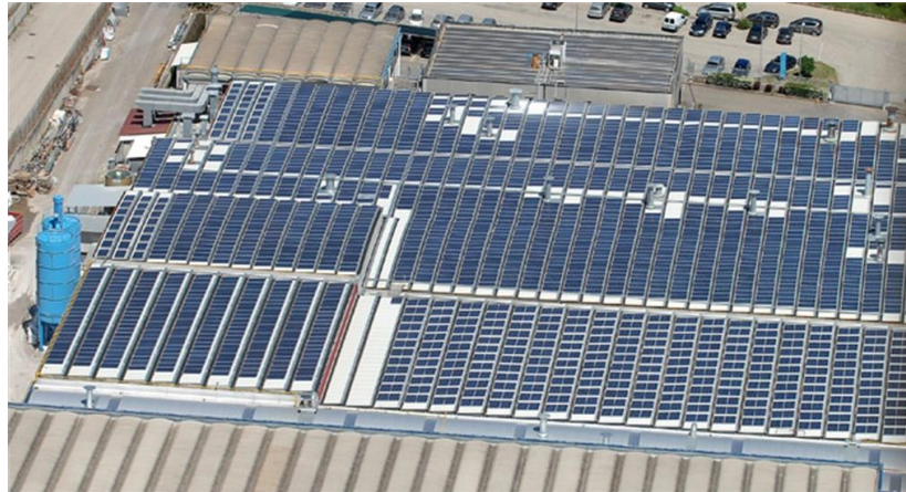
Figura 1: Stabilimento Galassia S.r.l. di Corchiano (VT).
