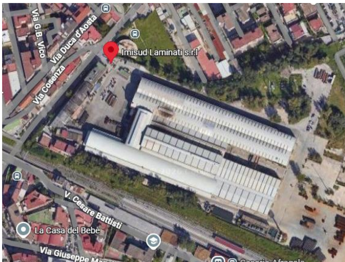
Figura 1: Stabilimento IMI SUD LAMINATI di Casoria (NA).
