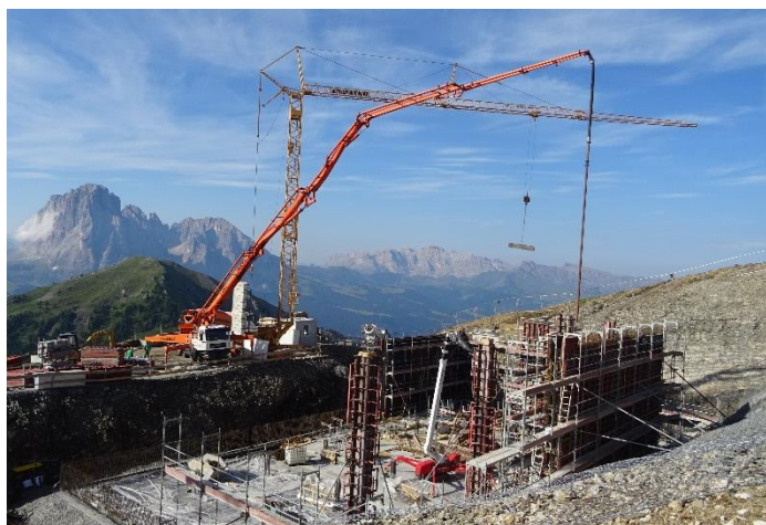
Getto del calcestruzzo
